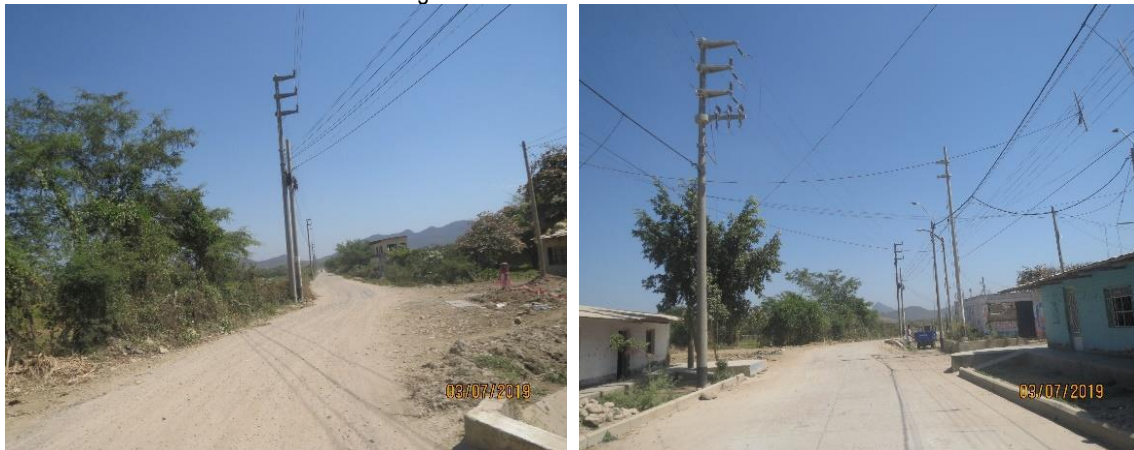
Imagen 1.7-3: Vistas de la ruta PE-1NR
