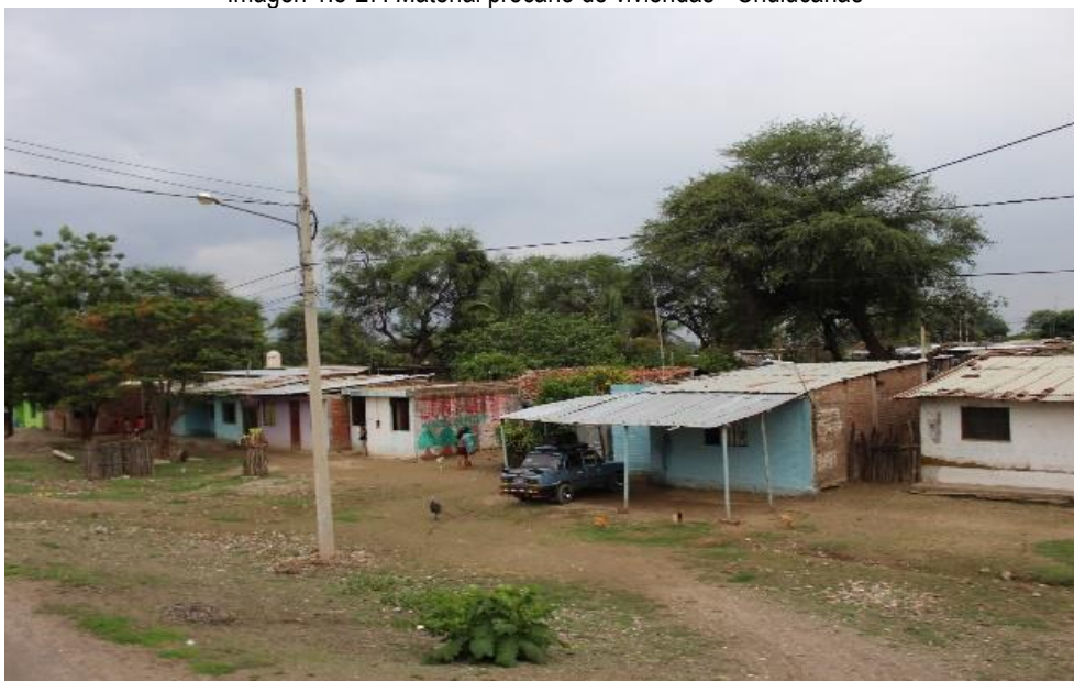
Imagen 1.3-27: Material precario de viviendas - Chulucanas
