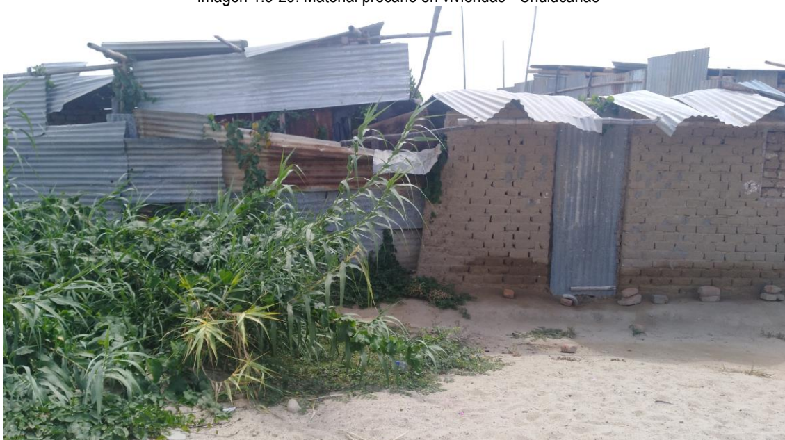
Imagen 1.3-29: Material precario en viviendas - Chulucanas
