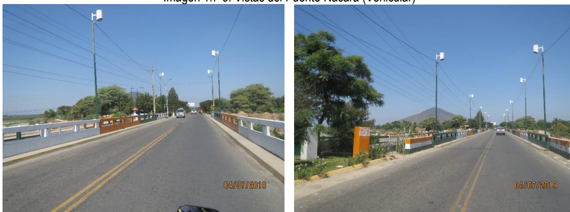
Imagen 1.7-9: Vistas del Puente Ñacara (Vehicular)
