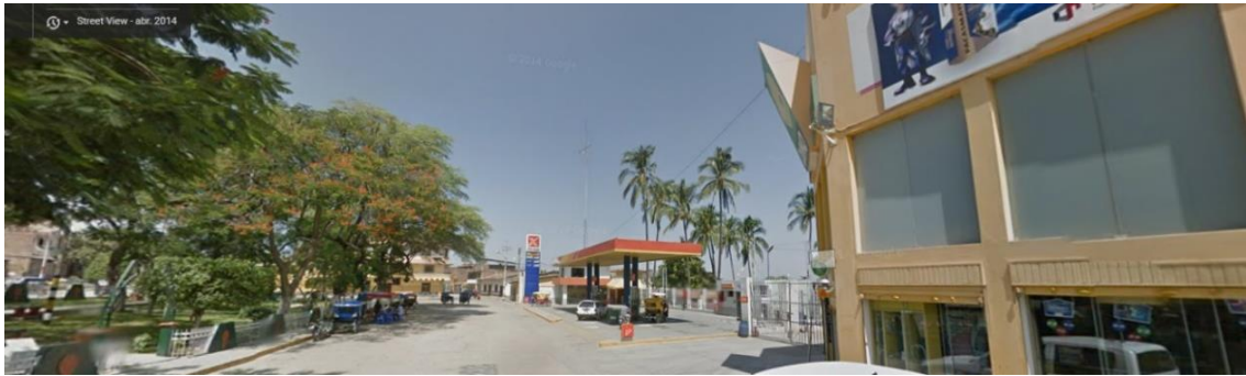
Imagen 1.3-17: Vista de estación de servicios – potencial peligro de explosión
