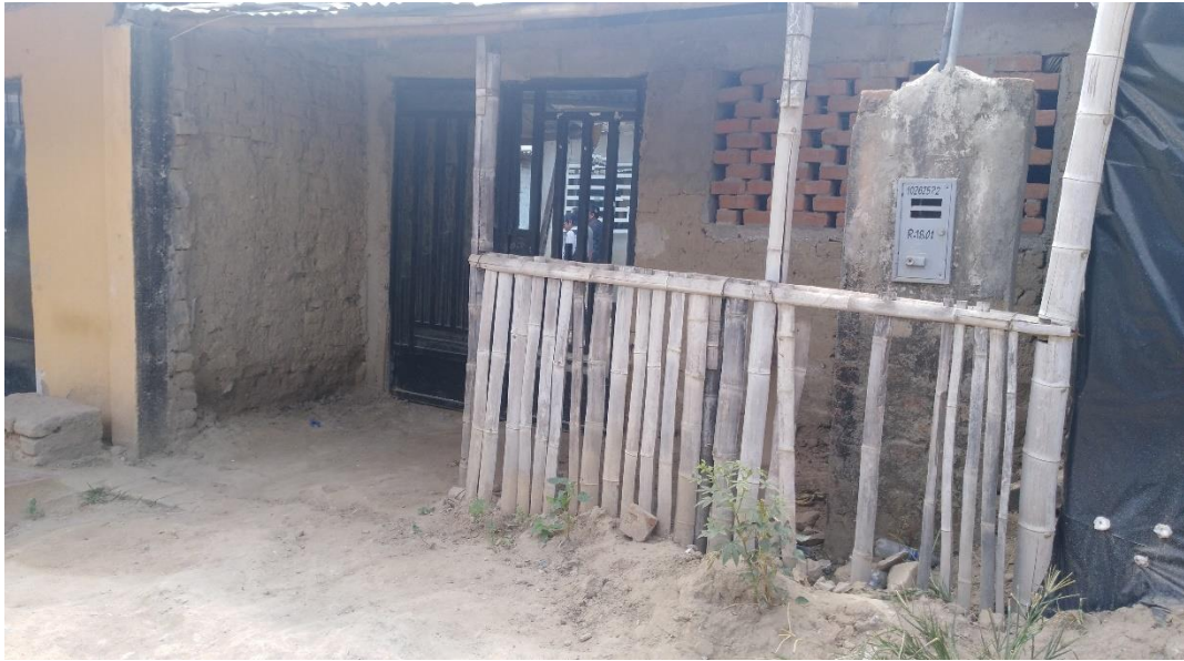
Imagen 1.3-4: Viviendas en el ámbito de intervención con servicios básicos.
