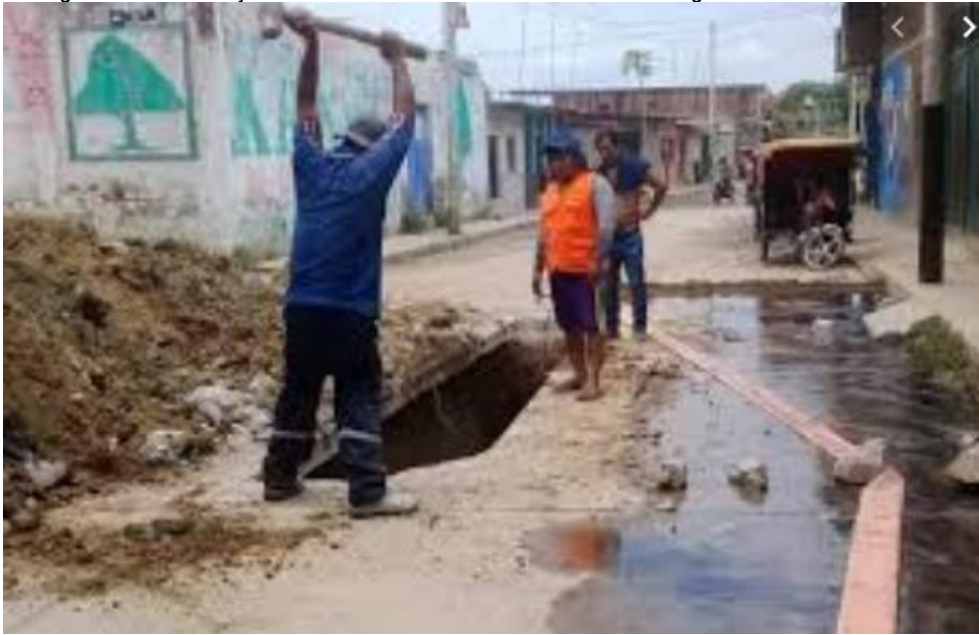
Imagen 1.7-25: Trabajos de mantenimiento - Colector - Red de desagüe - Ciudad de Chulucanas
