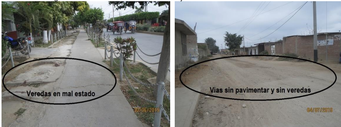
Imagen 1.10-29: Vista de las vías sin veredas y veredas en mal estado de conservación
