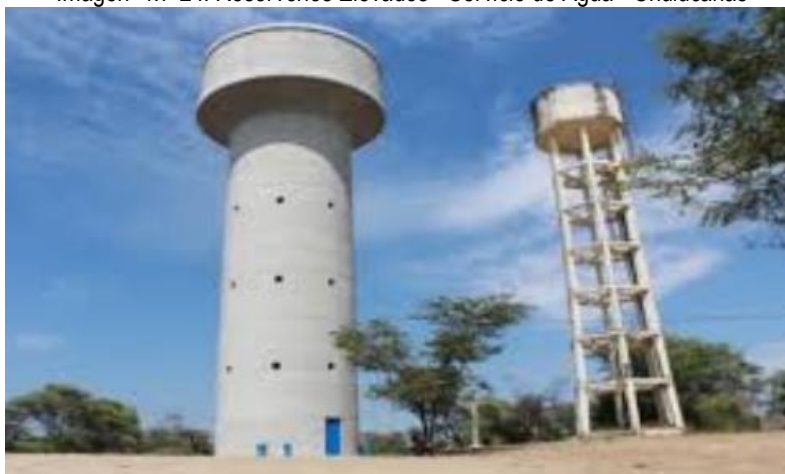
Imagen 1.7-24: Reservorios Elevados - Servicio de Agua - Chulucanas
