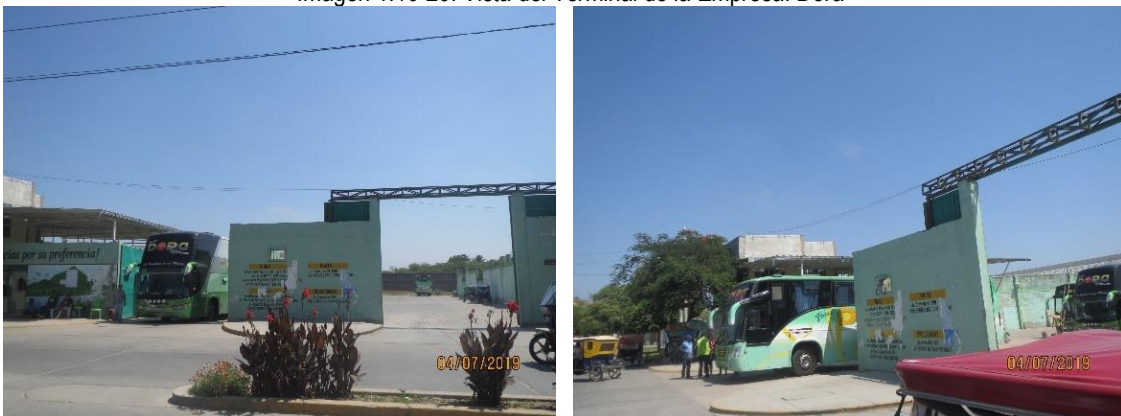
Imagen 1.10-20: Vista del Terminal de la Empresa. Dora
