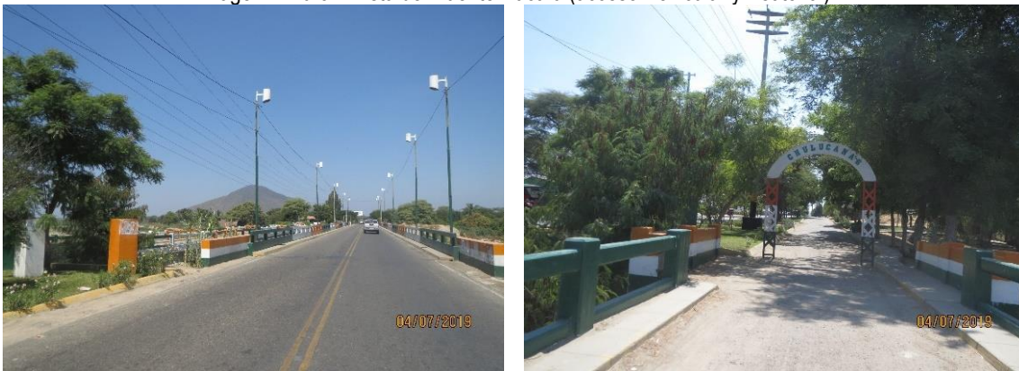
Imagen 1.10-34: Vista del Puente Ñacara (acceso Vehicular y Peatonal)
