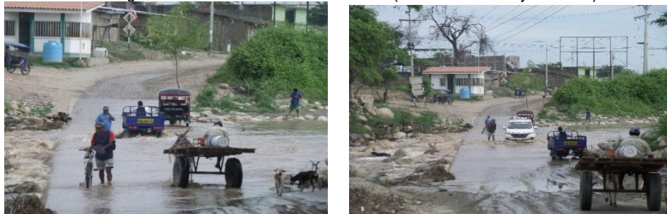
Imagen 1.10-35: Vista del Puente Ñacara (acceso Vehicular y Peatonal)
