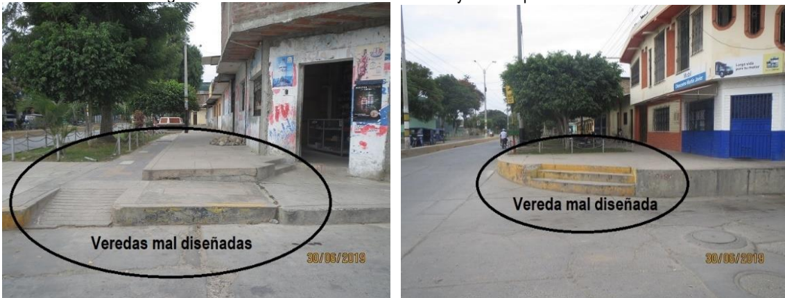
Imagen 1.10-28: Vista de las vías sin veredas y con rampas mal diseñadas
