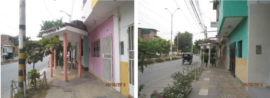
Imagen 1.10-11: Vista de interferencias en medio de la acera en la Av. Castilla
