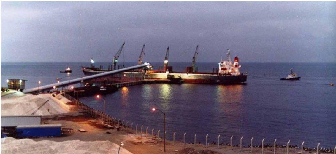
Imagen 1.1-10: Departamento de Piura: Muelle Multipropósito - Puerto Bayóvar
