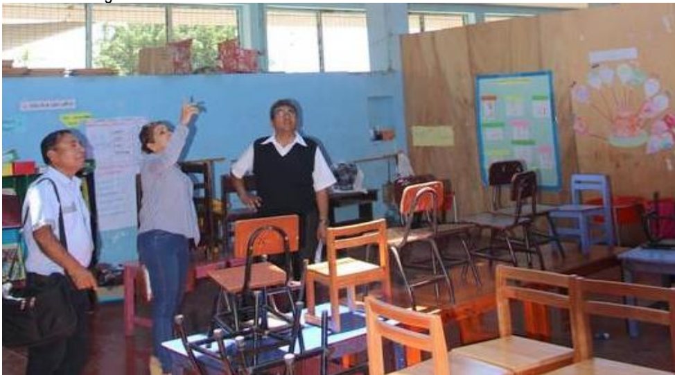
Imagen 1.7-5: Estado de una de las aulas de la I. E San Ramón – Chulucanas
