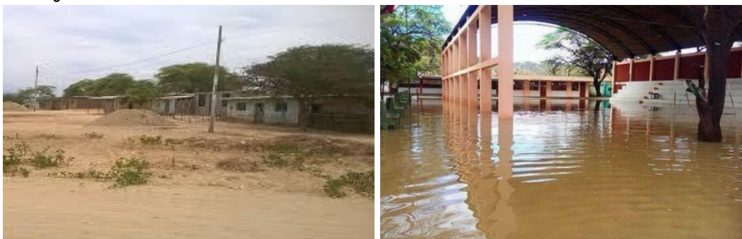
Imagen 1.3-11: Precariedad de viviendas e instituciones educativas en el Sector Nuevo Porvenir
