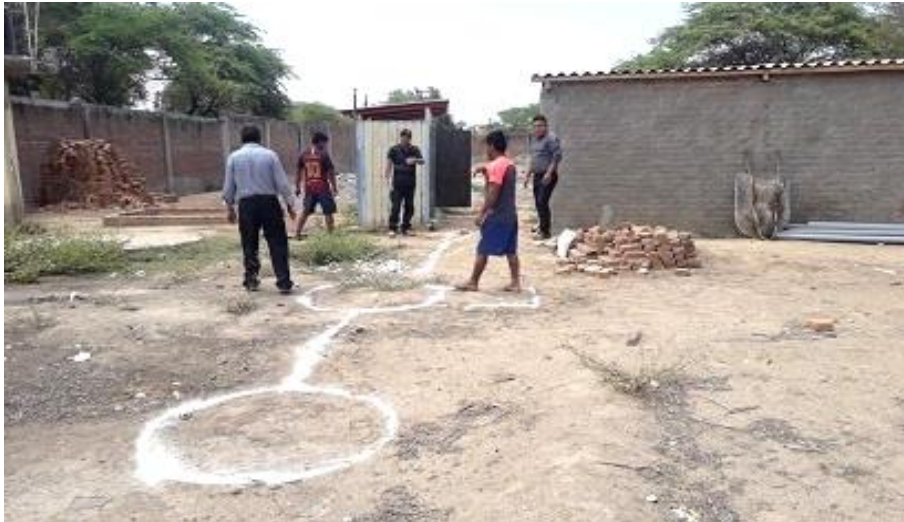
Imagen 1.7-14: Mejoramiento de los servicios de desagüe a través de Letrinas – C.P. La Matanza
