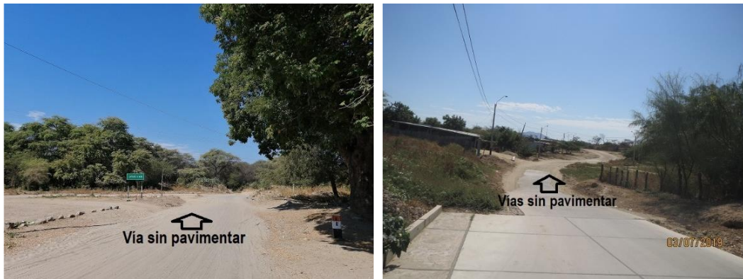
Imagen 1.10-23: Vista de las vías sin pavimentar
