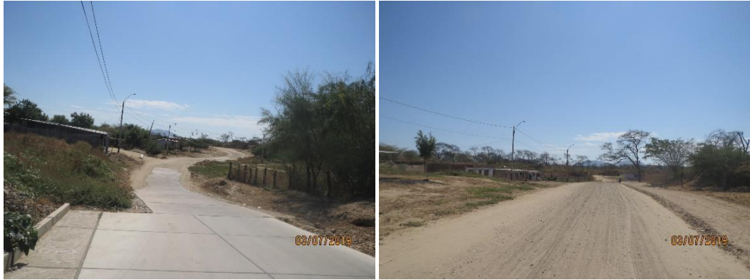
Ausencia de pavimentación
