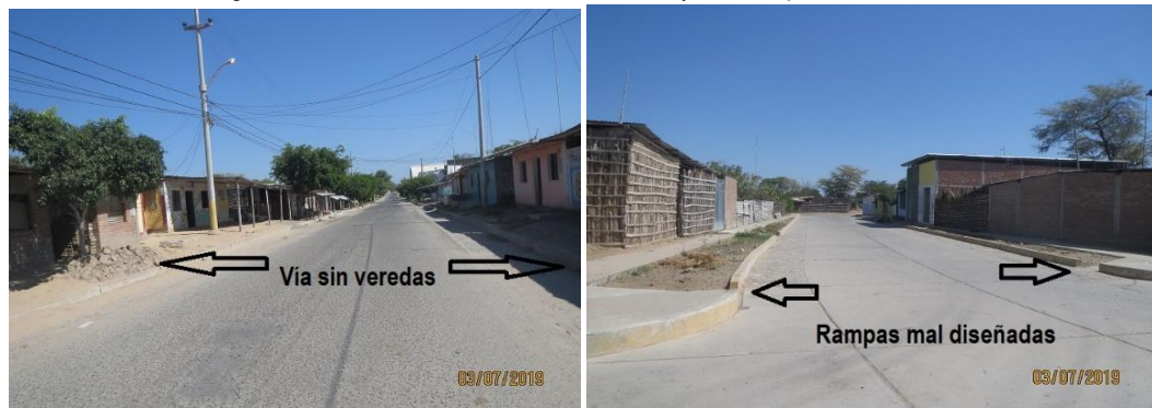
Imagen 1.10-22: Vista de las vías sin veredas y con rampas mal diseñadas
