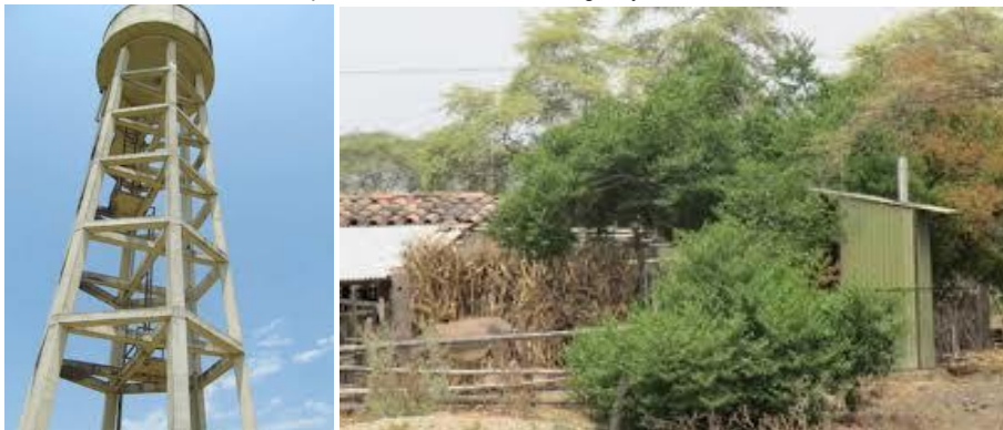
Imagen 1.7-15: Reservorio Elevado para abastecimiento de agua y vista de letrina en vivienda – C.P. Laynas
