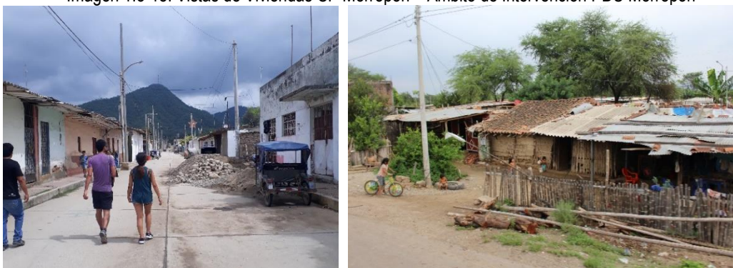
Estado de construcción de las viviendas del centro poblado de Morropón en estado regular y en deterioro.
