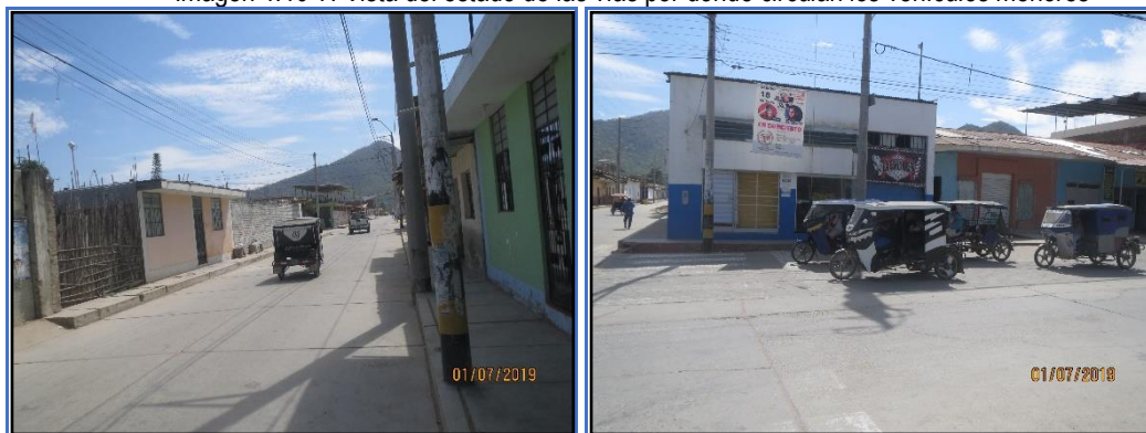
Imagen 1.10-7: Vista del estado de las vías por donde circulan los vehículos menores
