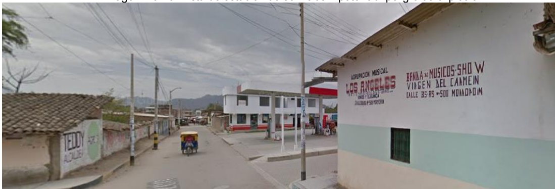
Imagen 1.3-16: Vista de estación de servicios – potencial peligro de explosión
