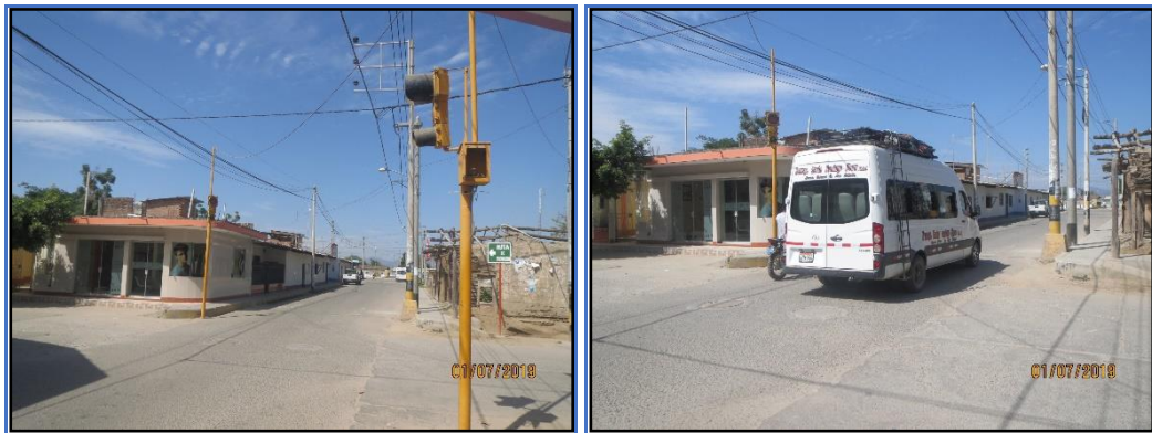
Imagen 1.10-29: Vista de la intersección semaforizada sin funcionamiento ubicada en el Jr. López y Ca. Piura
