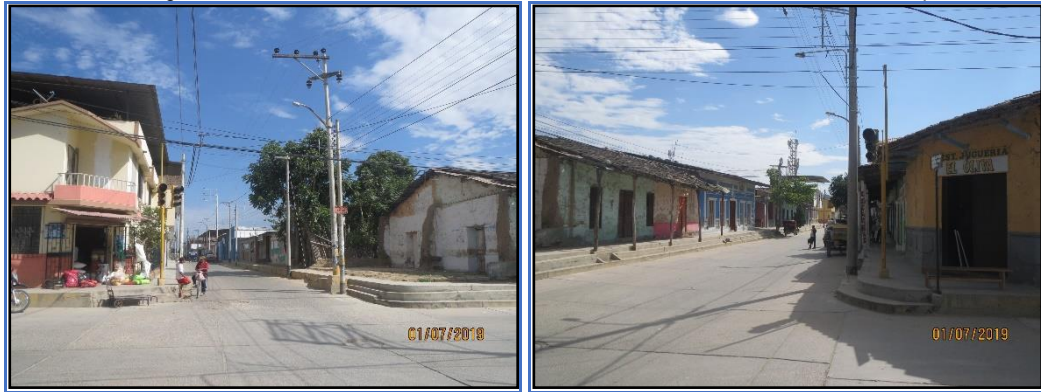
Imagen 1.10-26: Vista de la intersección semaforizada ubicada en Ca. Lima/Jr. López
