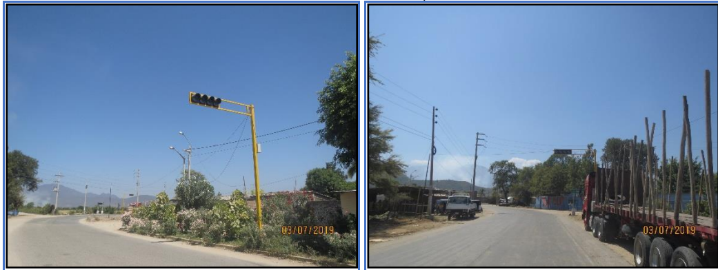
Imagen 1.10-28: Vista de la intersección semaforizada sin funcionamiento ubicada en la Av. Perú (Vía Nacional PE – 02C)
