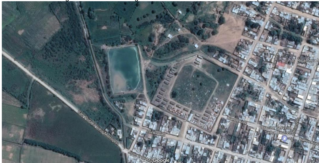
Imagen 1.7-11: Vista de Laguna de Oxidación de la ciudad de Morropón
