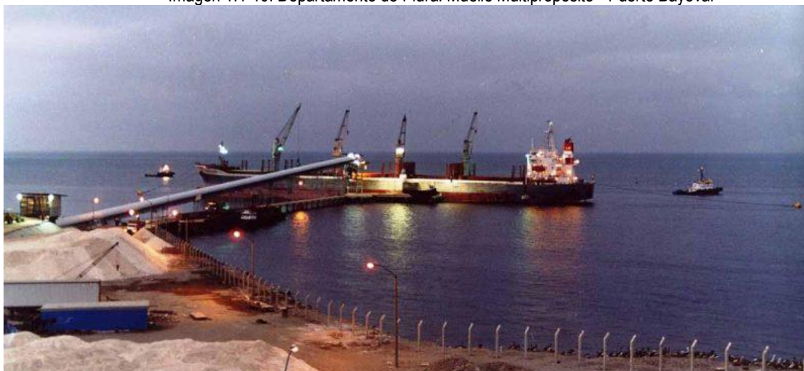
Imagen 1.1-10: Departamento de Piura: Muelle Multipropósito - Puerto Bayóvar
