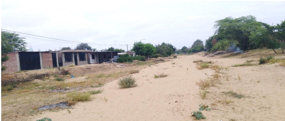
Imagen 3.5-1: Ausencia de Sistema de Drenaje Pluvial
